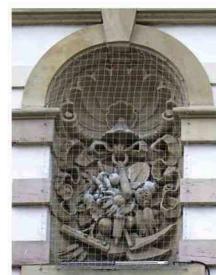
Die Fassade zur Buchbindergasse zeigt landwirtschaftliche Geräte zur Erinnerung ans Kornhaus.
